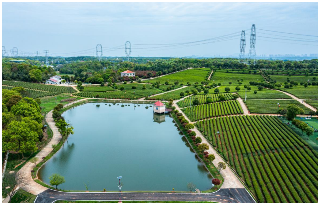
小微水体治理
